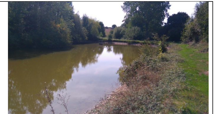
Vue du plan d'eau et de la digue depuis la rive gauche
