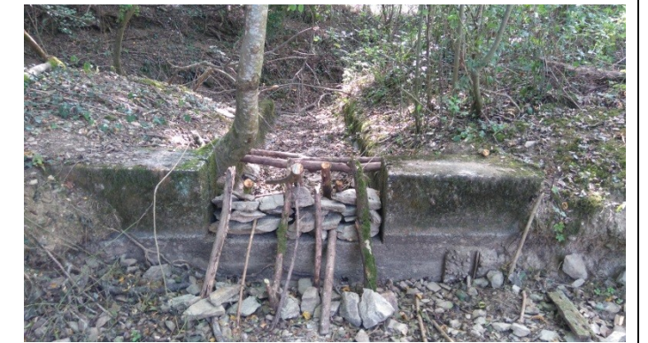
Déversoir de crue
